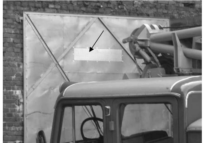
Das Belüftungsgitter, zu sehen über dem Dach des RKW.
