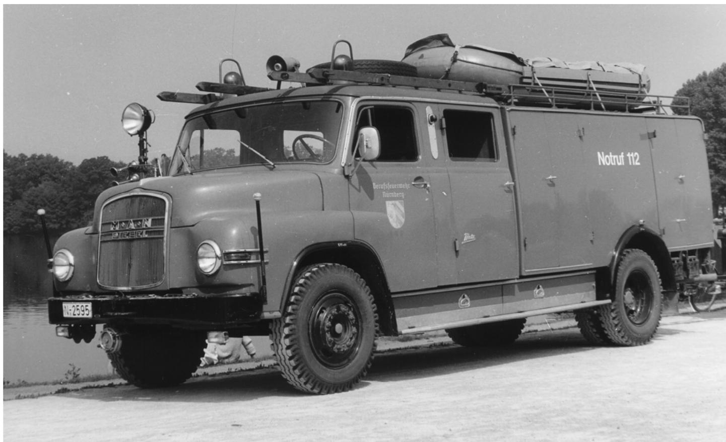
Fahrgestell: MAN 400 L1, 6 – Zylinder Dieselmotor mit 100 PS, Hubraum: 5211 cm<sup>3</sup>
