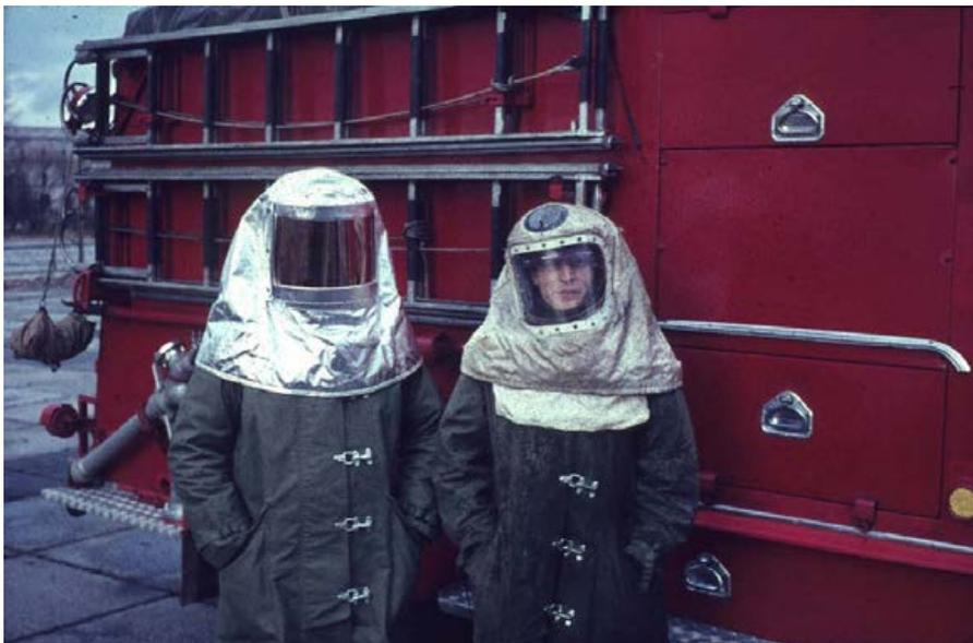
2 Feuerwehrmänner haben neben einem Löschfahrzeug Aufstellung genommen. Neben den schweren Schutzmänteln aus Wolle tragen sie die bis in die 1970er Jahre insbesondere bei Kraftstoffbränden nötigen Hitze-Schutzhauben mit Aluminiumbeschichtung. Die Anordnung der tragbaren Leitern seitlich am Aufbau war bei Feuerwehrfahrzeugen aus amerikanischer Produktion üblich und wurde auch bei den Fahrzeugen übernommen, die in Europa für die US Army gebaut wurden.
