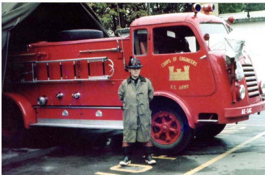
Neben einem Krupp-Südwerke Löschfahrzeug steht ein Feuerwehrmann in amerikanischer Schutzkleidung aus den 1950er Jahren bestehend aus einem knielangen schweren Schutzmantel,  $\frac{3}{4}$ -Stiefeln sowie dem Helm des Typs Skullgard der Firma MSA. Das Helmschild aus schwarzem und rotem Leder trägt die Aufschrift „USA FD“. Die Behelfsfahrzeughallen aus Zelten waren an vielen Standorten der US Army Feuerwehren in Deutschland bis in die 1950er Jahre weit verbreitet.
